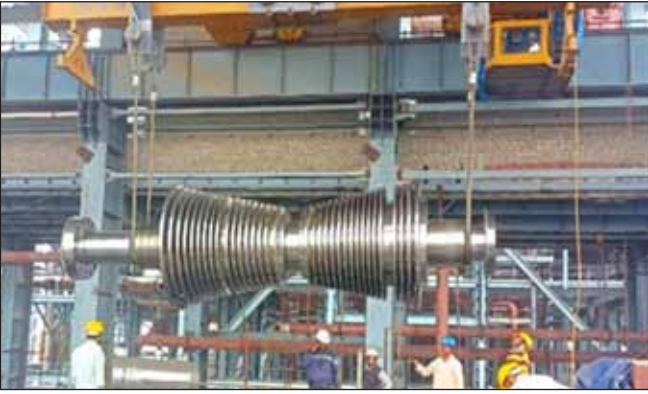
আই পি টারবাইন স্থাপনের কাজ চলছে
