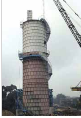
সাইলো স্থাপনের কাজ চলছে
